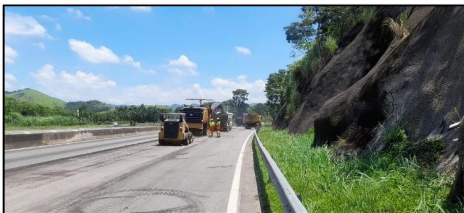
Figura 19: Comboio que acompanha a fresadora durante a operação
