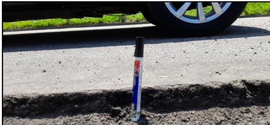
Figura 18: Profundidade da fresagem realizada na BR-116
