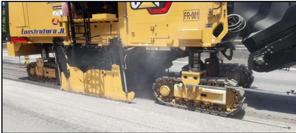
Figura 16: Fresadora PM620 em operação na BR-116
