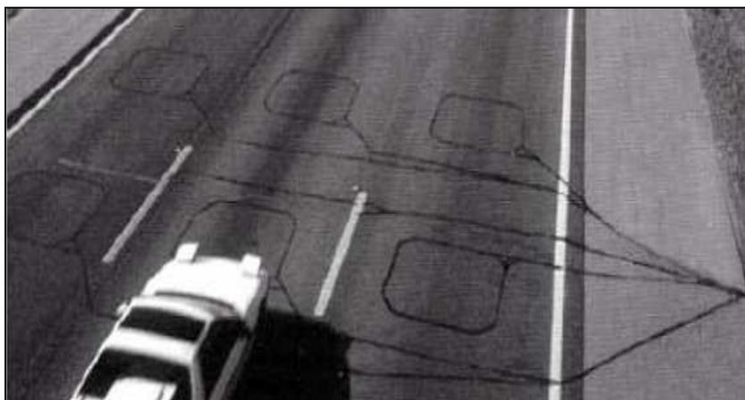
Figura 3.2: Laços indutivos instalados no asfalto
