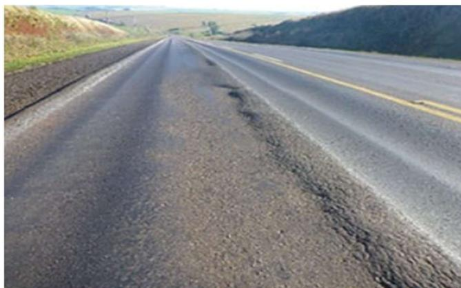
Figura 9 – Afundamento Plástico em Pavimento (CNT, 2018)
