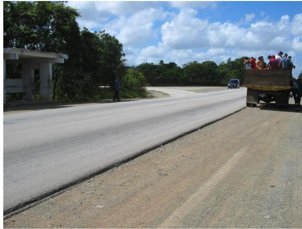
**Figura 3.6.** Desnível entre faixa de rolamento e acostamento.
