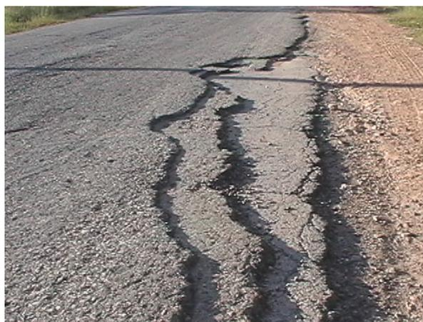
**Figura 3.8.** Buracos e perda do revestimento do pavimento.
