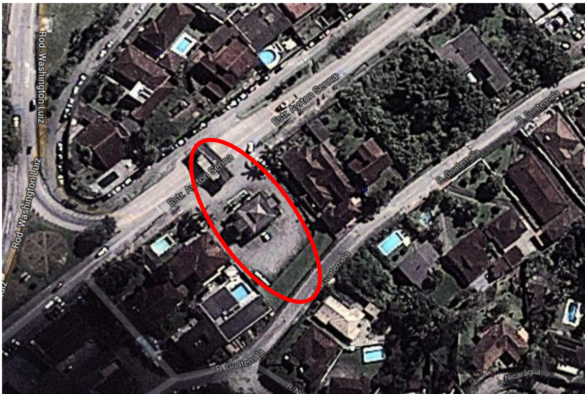
Figura 5.8: Terminal de Transferência Avenida Ayrton Senna.
